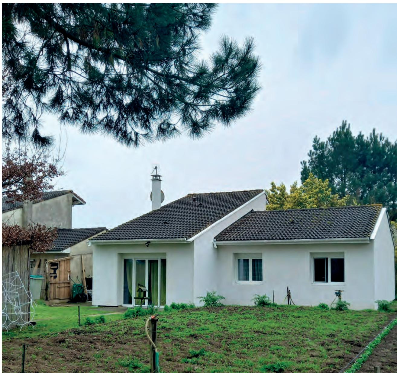
Résidence Bois Bourru, à Etauliers 7 logements individuels réhabilités dans un quartier pavillonnaire et bientôt promis à la vente
