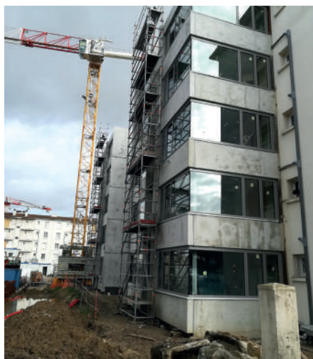
Le chantier avec l'ajout des nouvelles surfaces par l'extérieur
