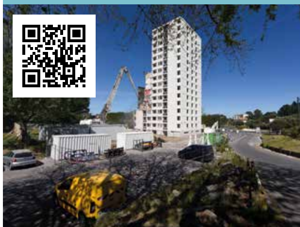
Démolition de la tour en mai 2017
