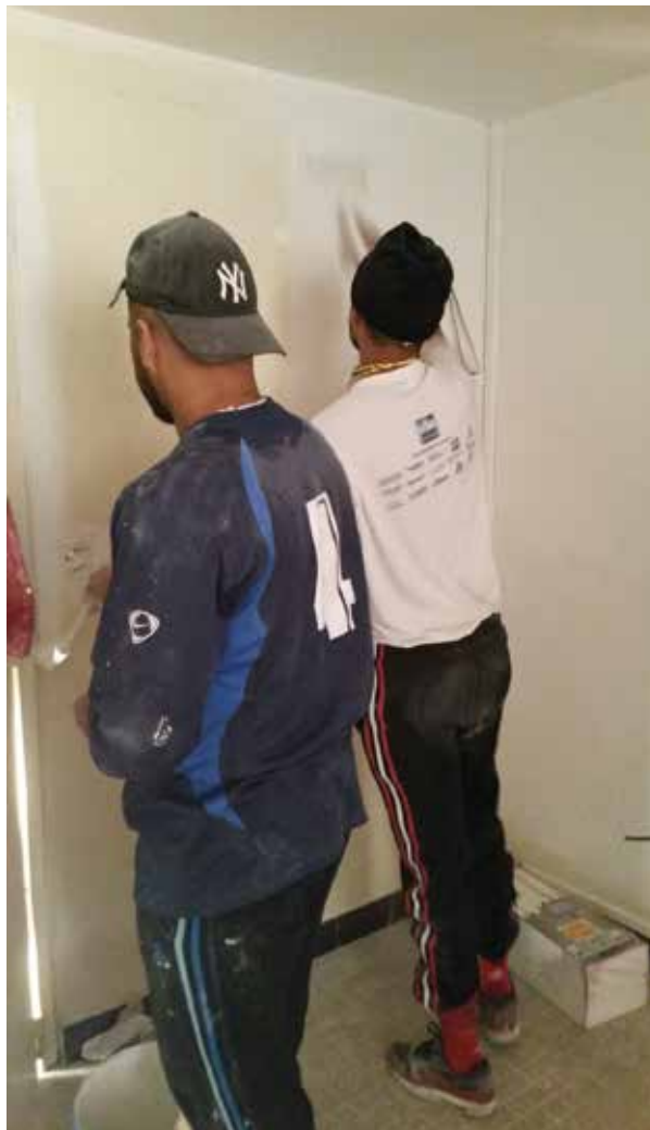
Chantier insertion encadré par le Centre Technique de Gironde Habitat
