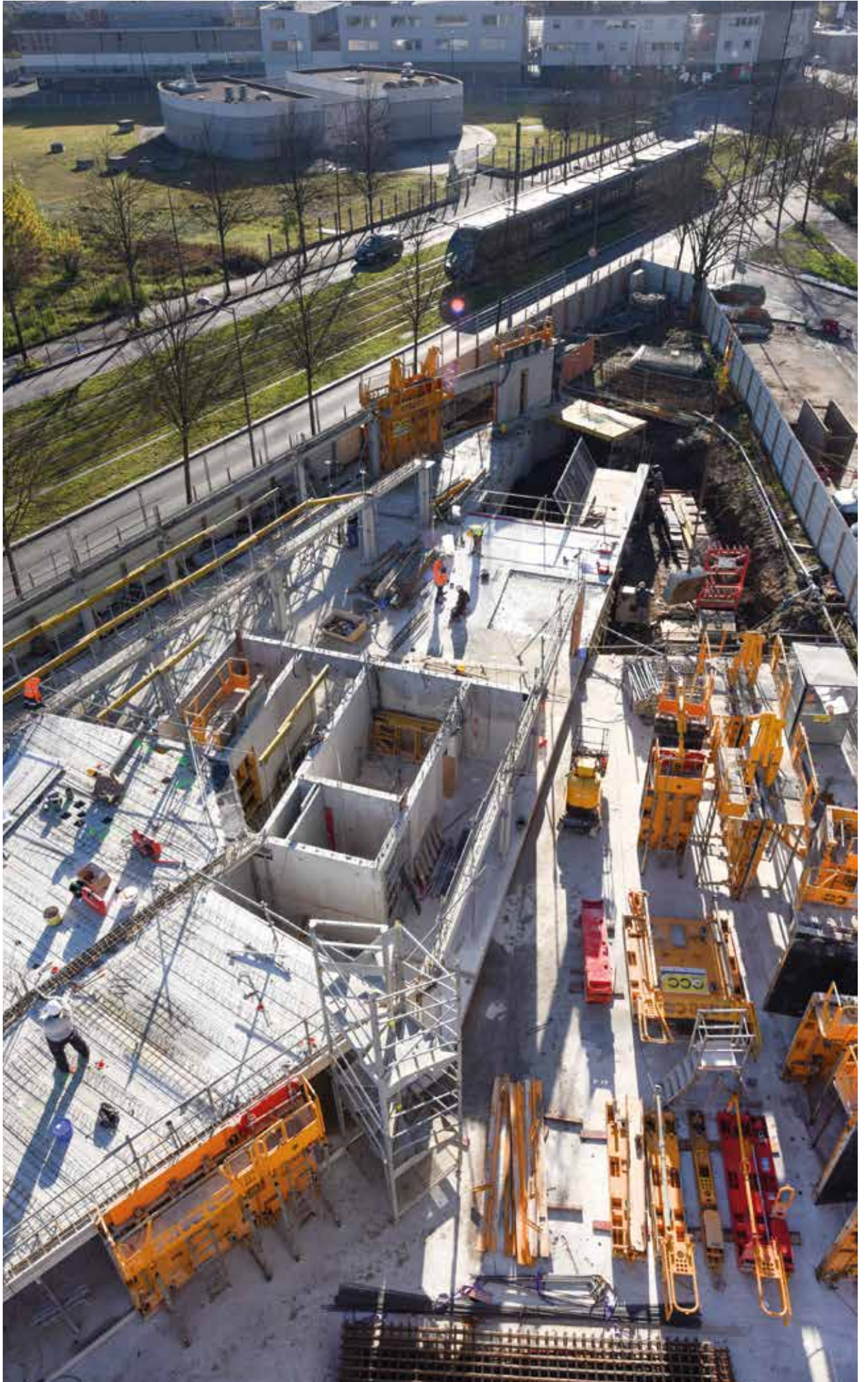
Chantier de la résidence Florestine à Bordeaux
