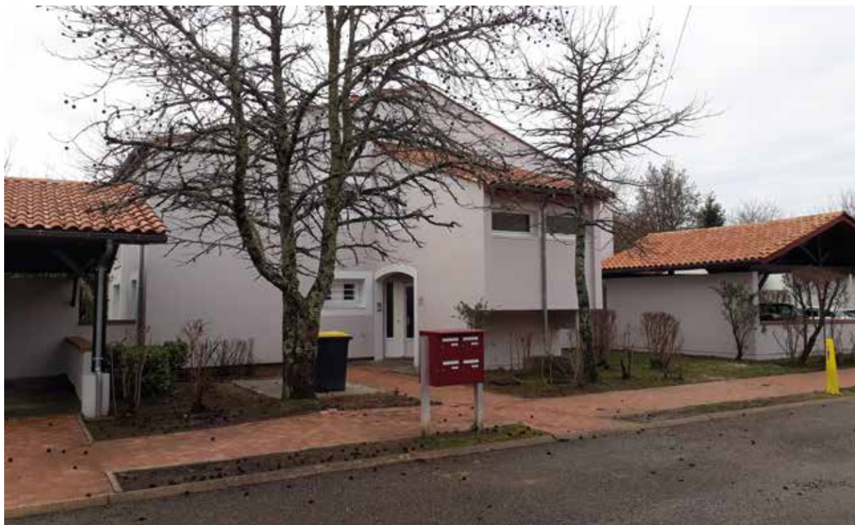
Réhabilitation de la résidence Peyre - St Seurin de Cursac
